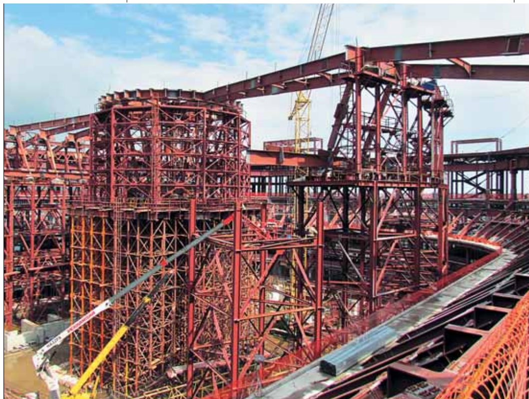
Строительство дворца зимнего спорта «Айсберг»
